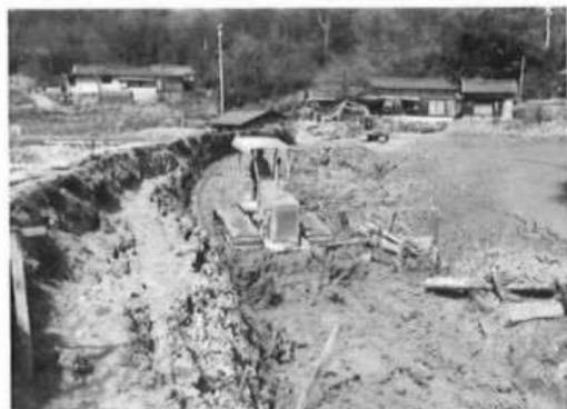
下池の改修工事
