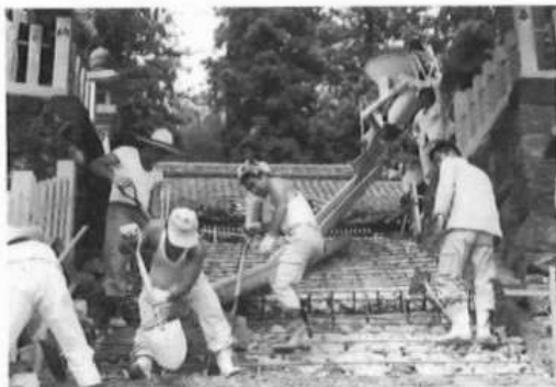
石段の改修工事
