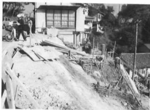
がけ崩れした上野の急斜面
