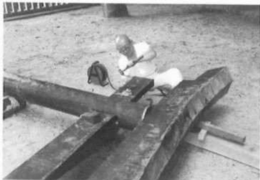
銅巻鳥居の修理
