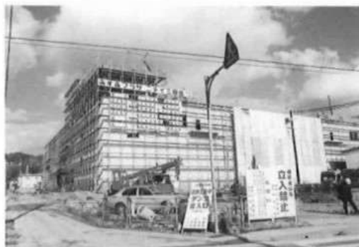
ニチイの建設工事
