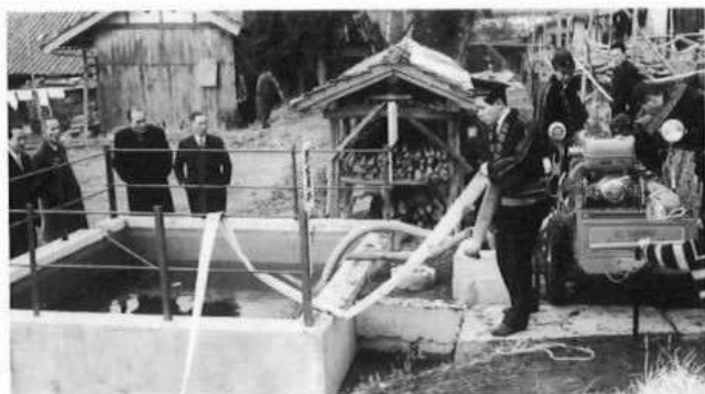
防火水槽の設置
